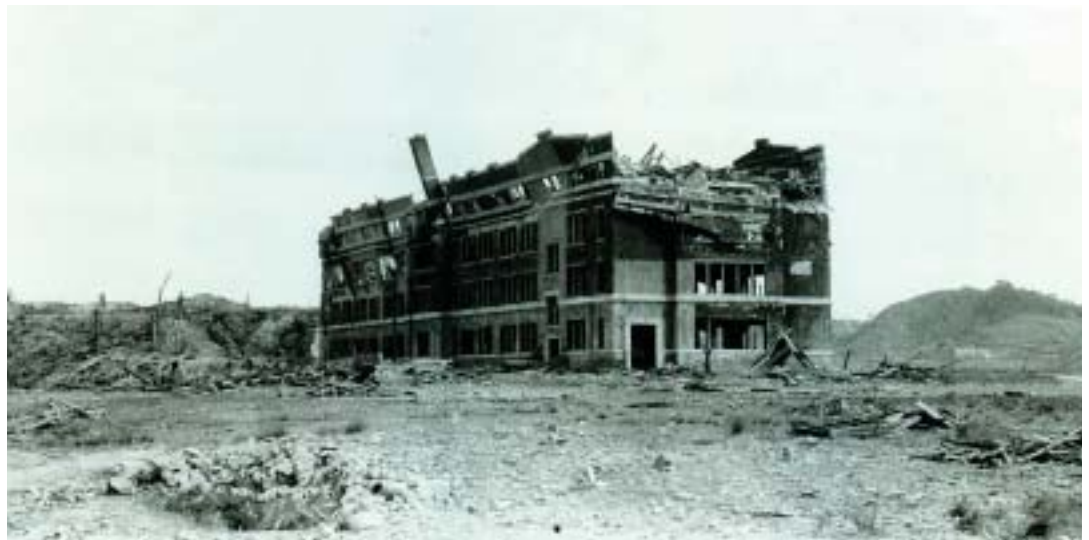
鎮西学院中学校校舎南西側より見る:D
