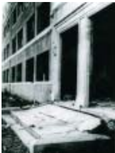
校舎東側玄関付近:E
