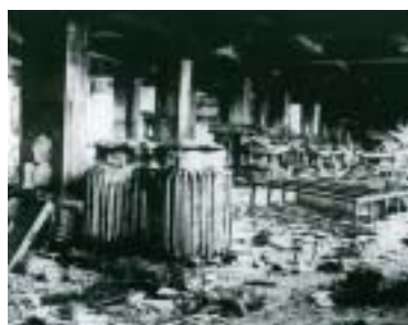
校舎1階内部の損傷:E
