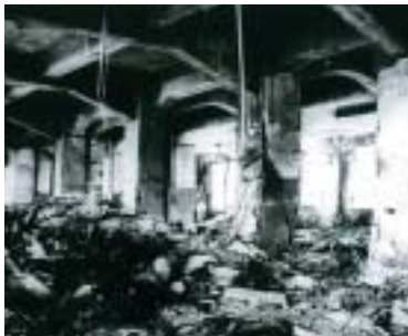
校舎2階爆風と火災による室内の損傷:C
